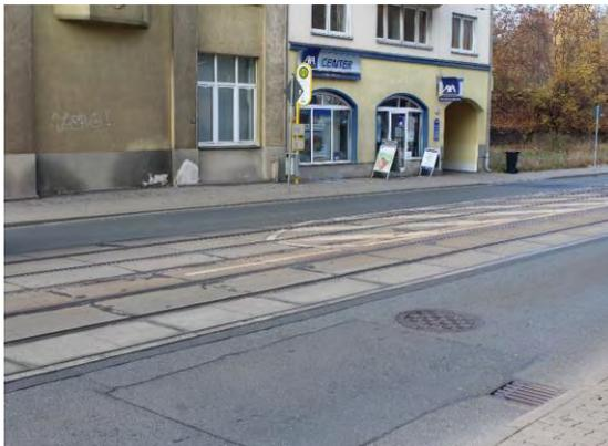
Foto: Nicht barrierefreie Haltestelle und Gleiseindeckplatten aus Beton, Hofer Straße
