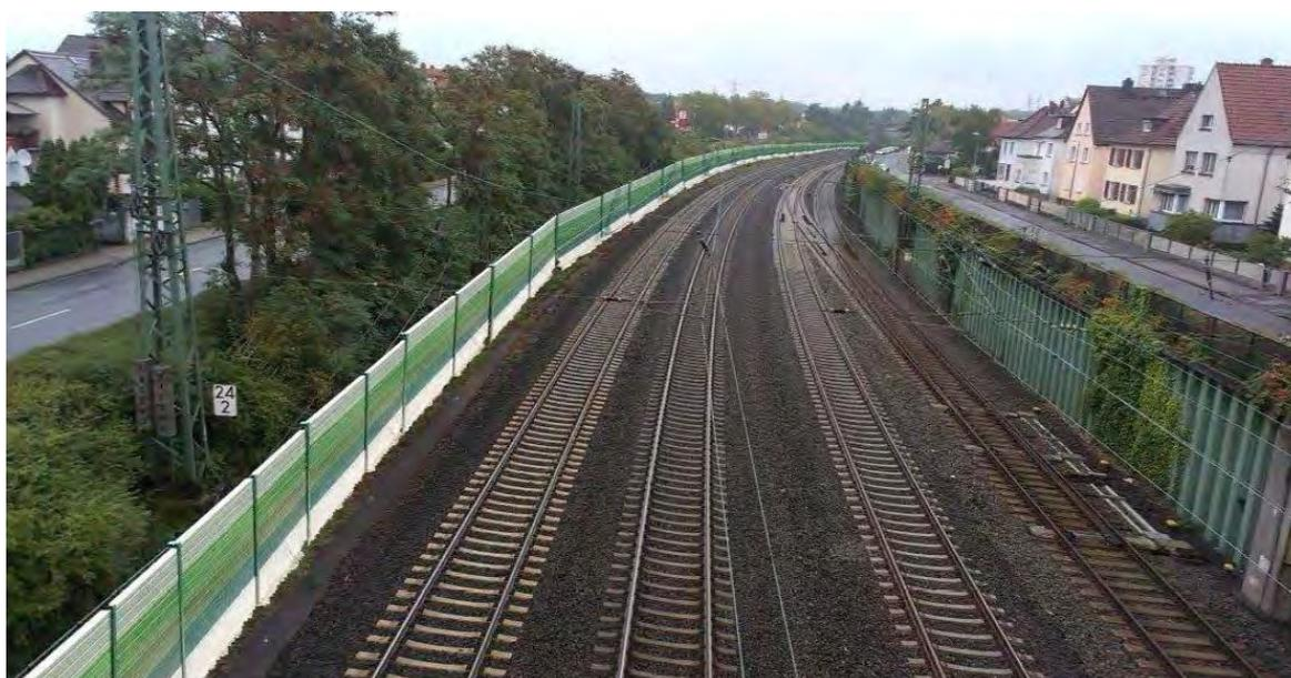
Foto: Beispiel für Lärmschutz entlang einer Haupteisenbahnstrecke
