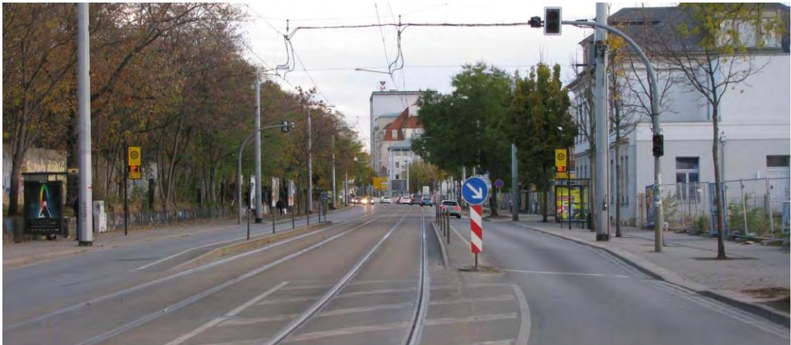
Foto: Beispiel einer barrierefreien Haltestelle, Führung in Mittellage, angehobene Kfz-Fahrbahn, Dresden
