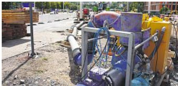
Das Wasser der Syra wird mittels Absaugpumpe umgeleitet.
